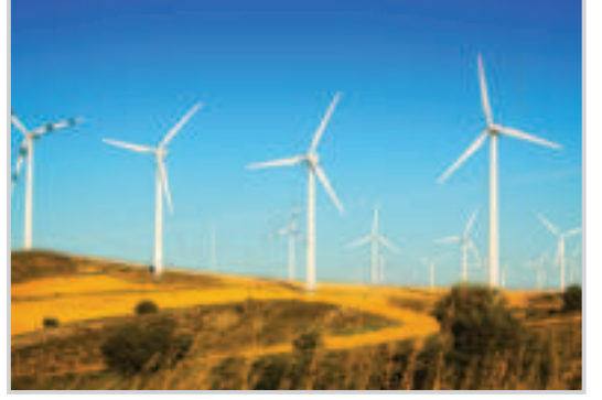
▲ Rüzgâr türbini (rüzgâr enerjisi santrali)
